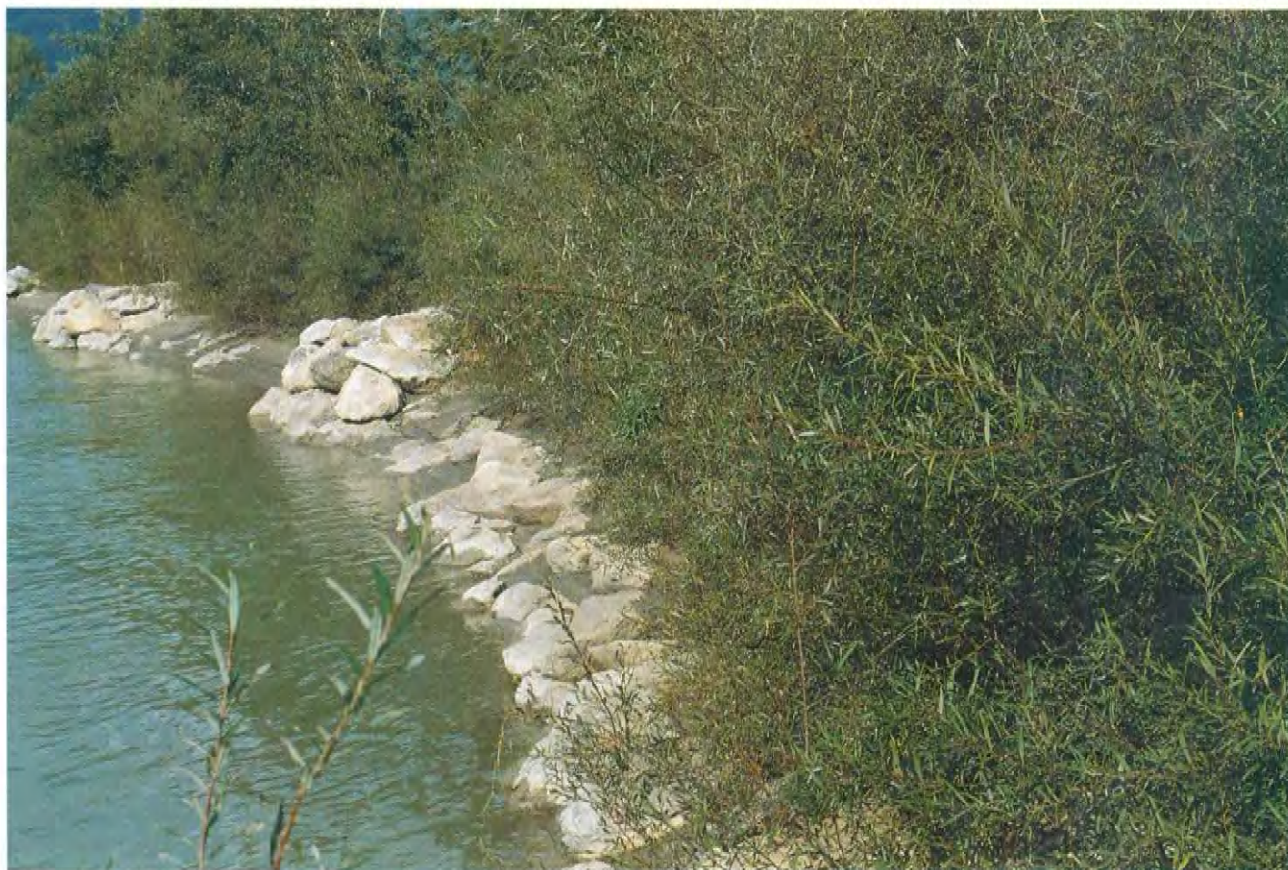
TAV. N. 31 Copertura diffusa con astoni di salice (dopo 3 anni) (Rio Aurino, Val Pusteria - Bz) Tipologia n. 20
