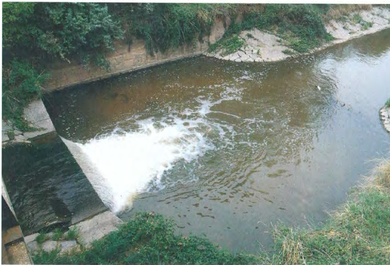
TAV. N. 39 Briglia in calcestruzzo (situazione prima della realizzazione della rampa in pietrame) (Fiume Pfrimm) Tipologia n. 26 a10
