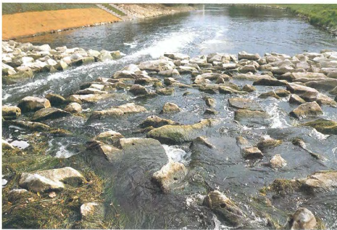
TAV. N. 44 Rampa in pietrame (la presenza di zone a corrente rapida e a corrente lenta favorisce la risalita della fauna ittica) (Fiume Danubio) Tipologia n. 26 a5
