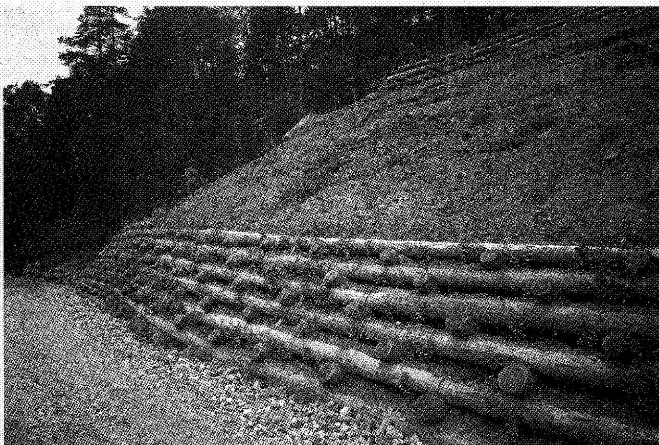
Foto n. 1 - Palificata in legname con messa a dimora di piantine (al termine della fase di costruzione) (San Genesio - Bz) Tipologia n. 14
