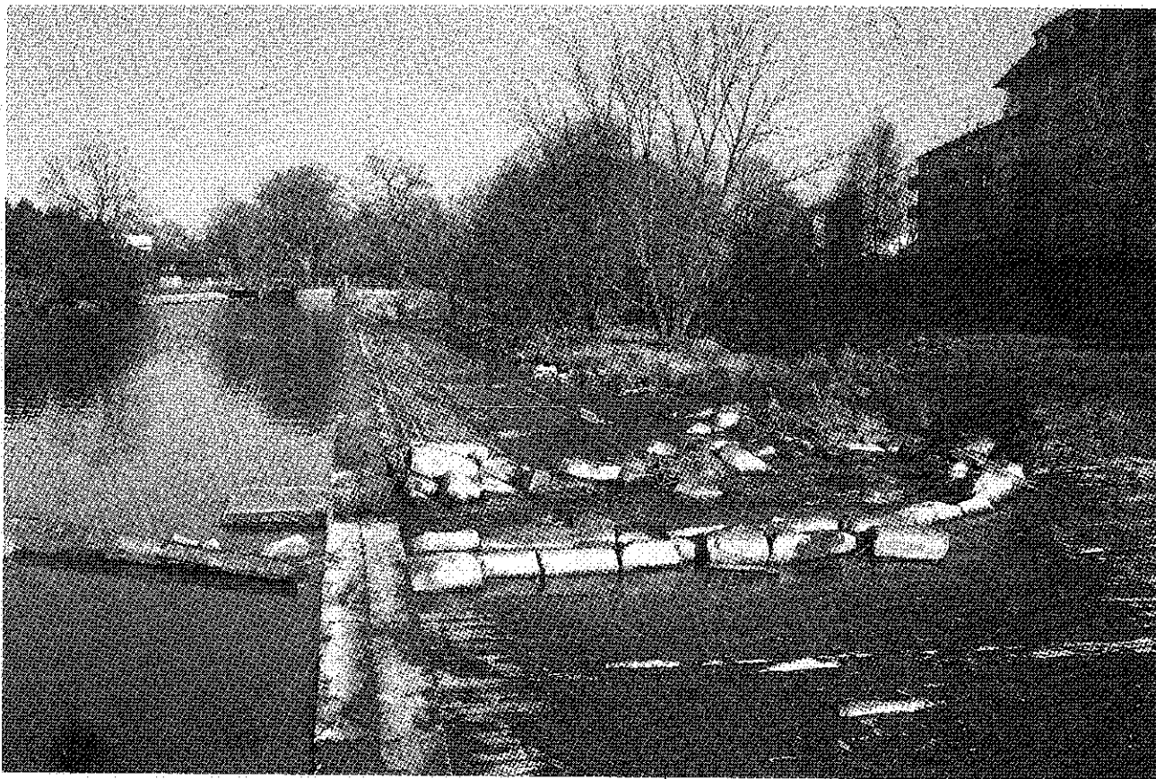
Foto n. 7 - Rampa in pietrame (passaggio per pesci inserito in un'opera trasversale - durante una portata di magra) (Fiume Nagold) Tipologia n. 26 b2
