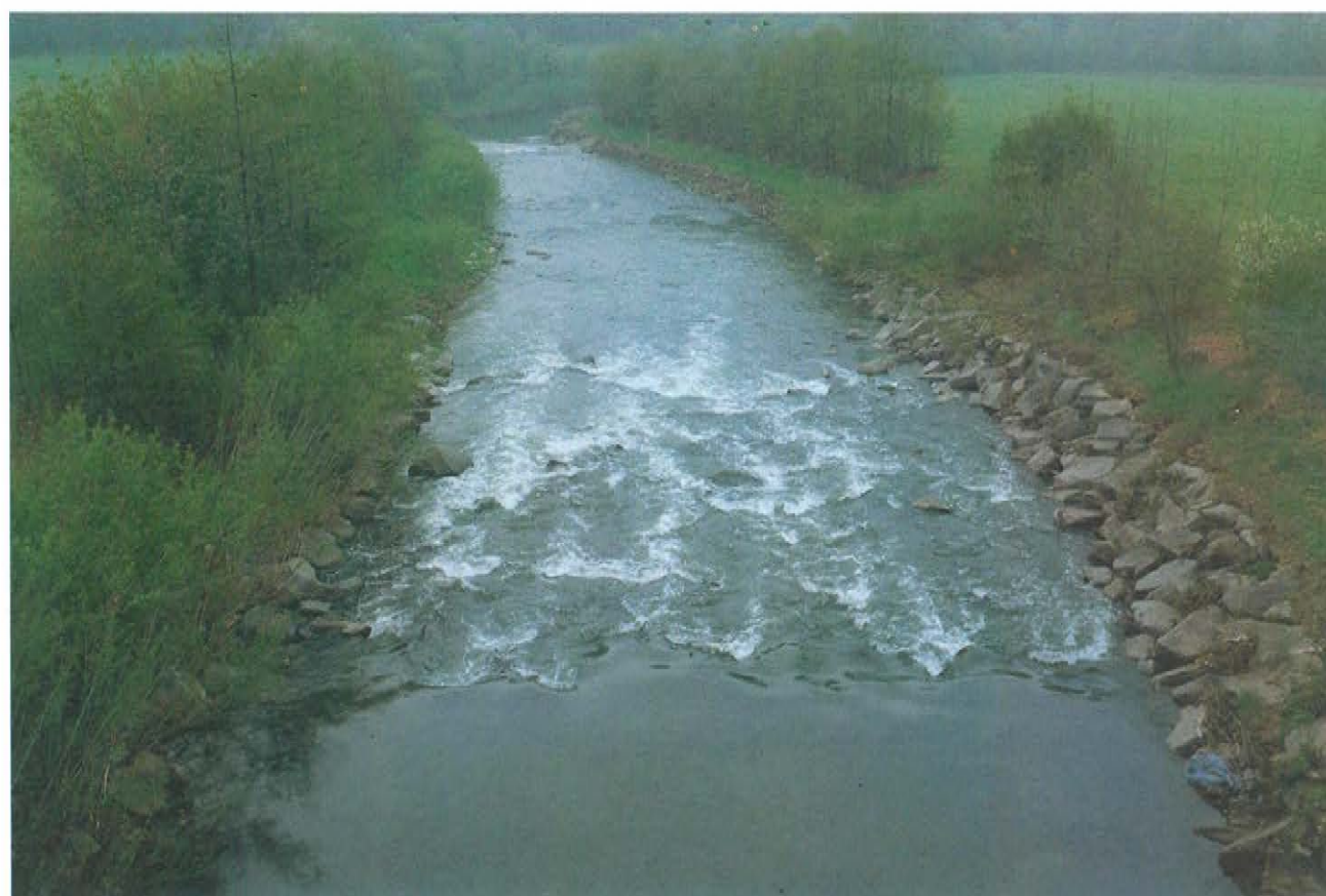
TAV. N. 36 Rampa in pietrame: consolidamento delle sponde con posa in opera di pietrame e piantagione di salici (il pietrame è stato collocato in modo irregolare per diversificare la morfologia dell'alveo) (Fiume Murr) Tipologia n. 26 a2
