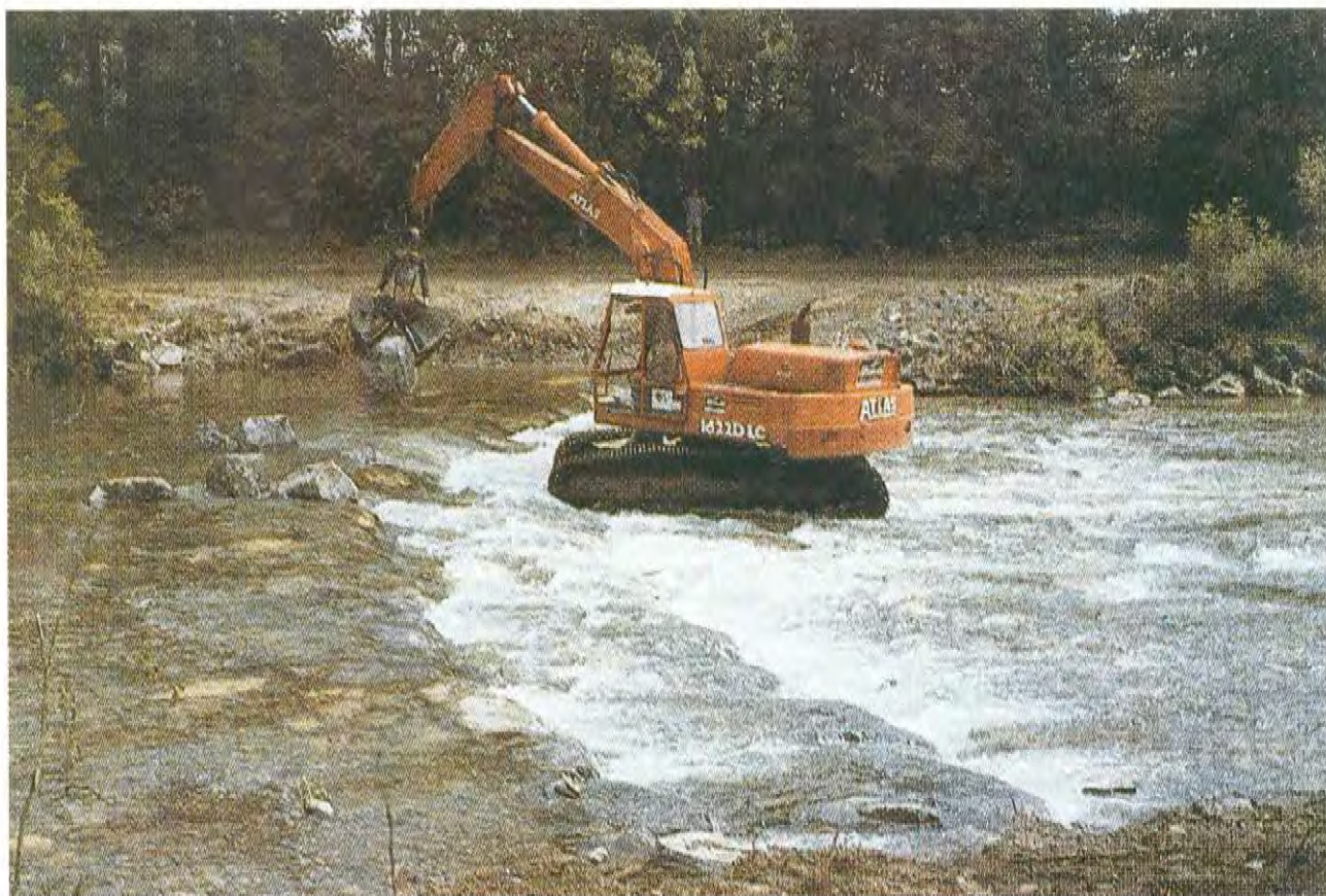
TAV. N. 41 Rampa in pietrame (posa in opera dei massi con mezzo meccanico) (Fiume Argen) Tipologia n. 26 a3
