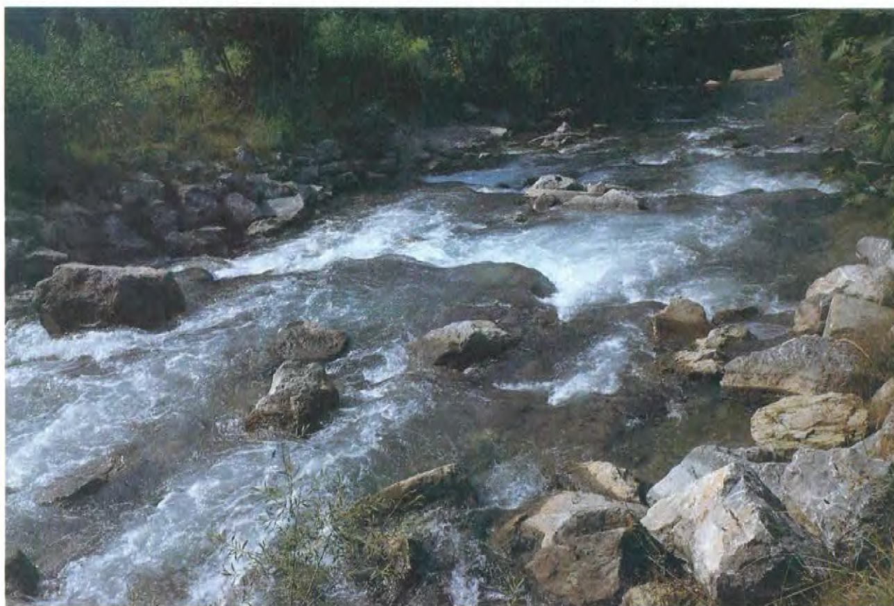
TAV. N. 38 Rampa in pietrame (realizzata eliminando la briglia in calcestruzzo al fine di diversificare la morfologia dell'alveo - vista da monte) (Fiume Leitzach) Tipologia n. 26 a9
